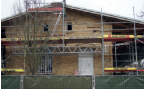
Güterboden im Bau
